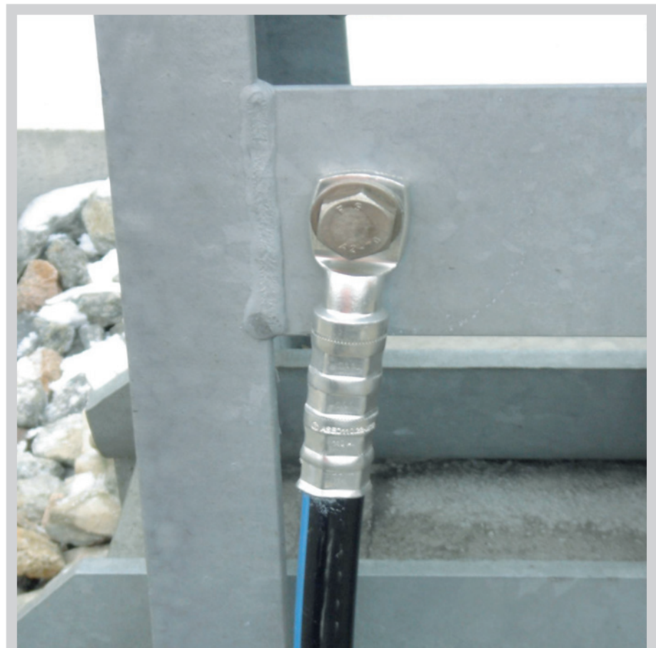
Bild 2: Die Anschlussschellen werden wasserdicht mit dem Kunststoffmantel verpresst.
